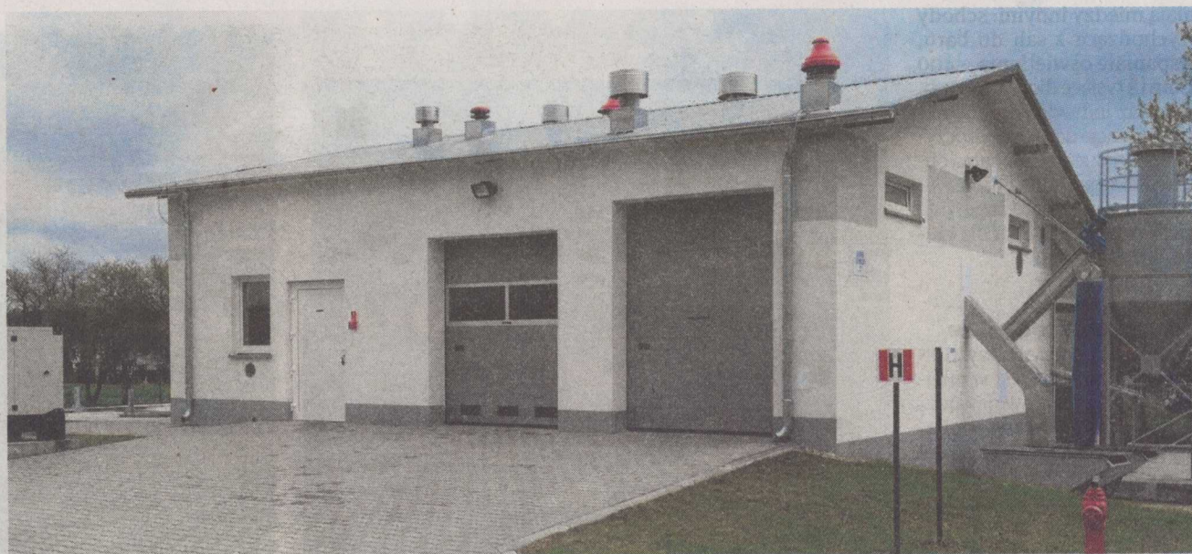
► Elektrociepłownia w Rosnowie nadal zamierza inwestować w ochronę środowiska naturalnego
